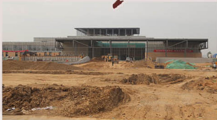
正在建设中的博物馆 The construction site of the new museum
