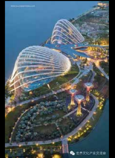
新加坡生态园
